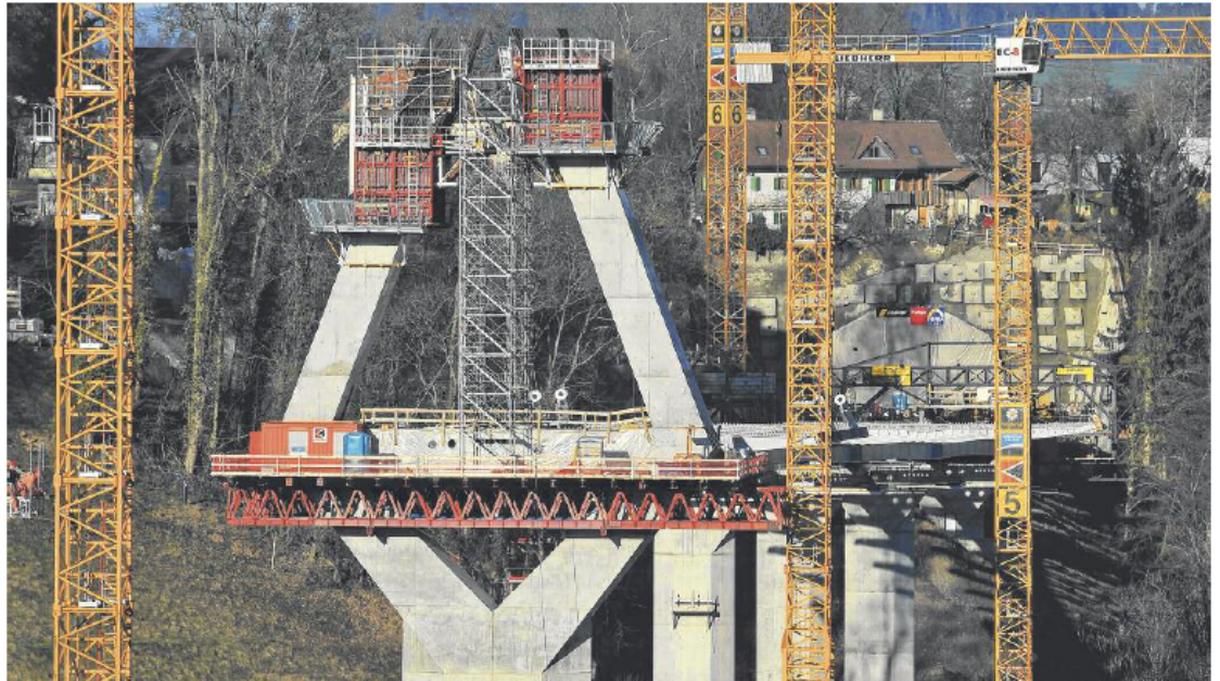
Zurzeit wird auf der Baustelle des Poya-Projekts wöchentlich rund eine Million Franken verbaut.
