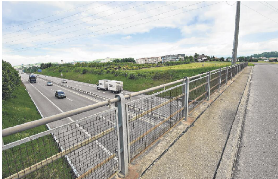
Bei der einen Variante führt die Umfahrungsstrasse unter der Autobahn A12 durch, bei der anderen geht sie darüber.
